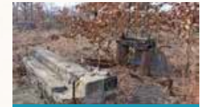
Puestos de bomba de aceite de hormigón de 1911-1945
