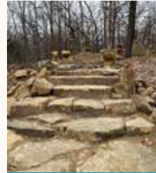
Escalera de piedra construida en 2023
